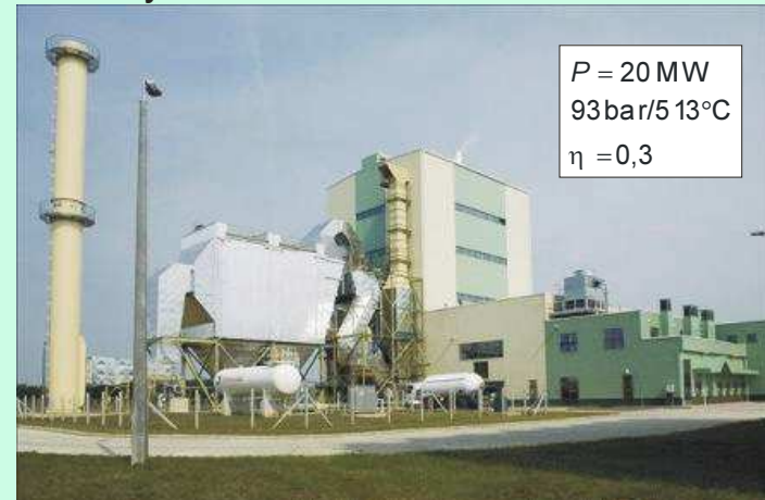
Szakolyi biomassza kondenzációs erőmű
