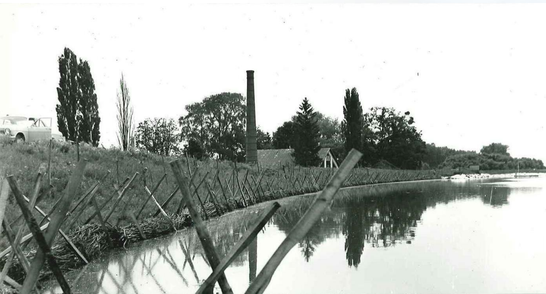
Hullámverés elleni védelem öllós karózással
