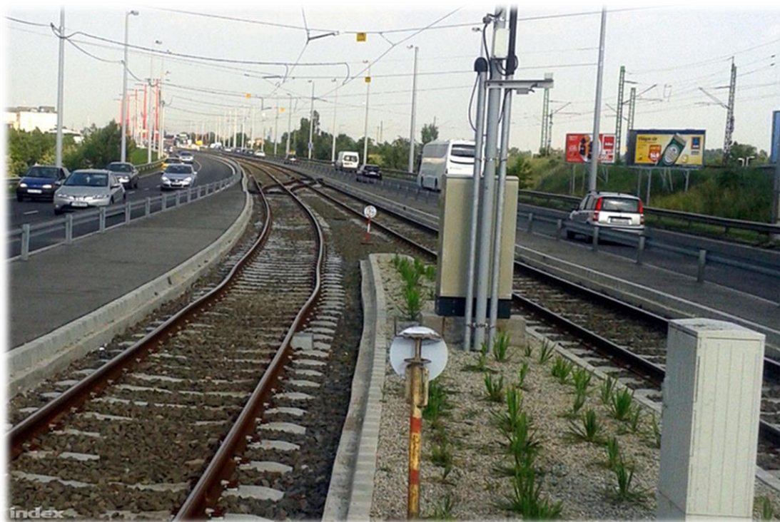
1-es villamos vágánya a Rákóczi híd Budafoki út/Dombóvári úti megállója előtti szakaszon
