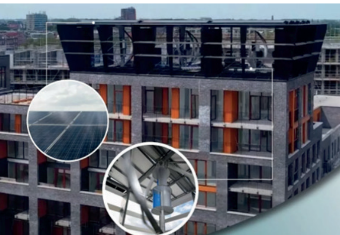
5. ábra. Az Ibis Power által fejlesztett PowerNEST hibrid rendszer egy épület tetején. (Forrás: desighboom.com).
