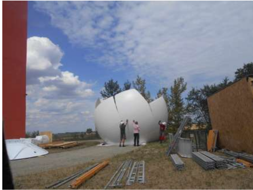
A radar-antennát takaró radom összeszerelése a 2014. június 16-i helyszíni telepítésen
